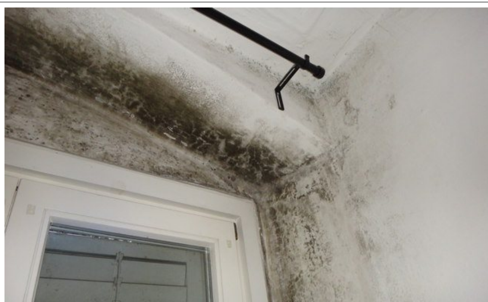
Fig. 1 Schimmel im Schlafzimmer eines Altbaues
