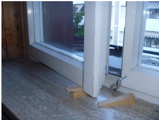
Fig. 9: Beispiel für einen Doppelkeil zum Fixieren des Fensters auf die gewünschte Spaltbreite
